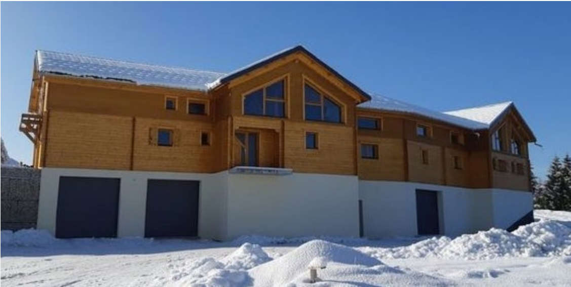
Auto-construction mixte Coffrage Isolant et Ossature Bois Gite Rural à Septmoncel (Jura)
