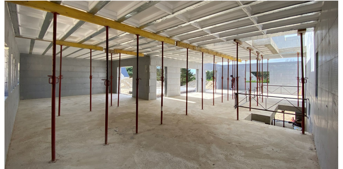
Réalisation Collart Bâtiment (Cucq 62) Maison individuelle RT2012 à Stella Plage (62)
