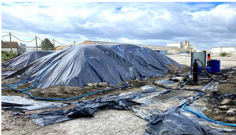
Figure 2 : Installation du biotertre
