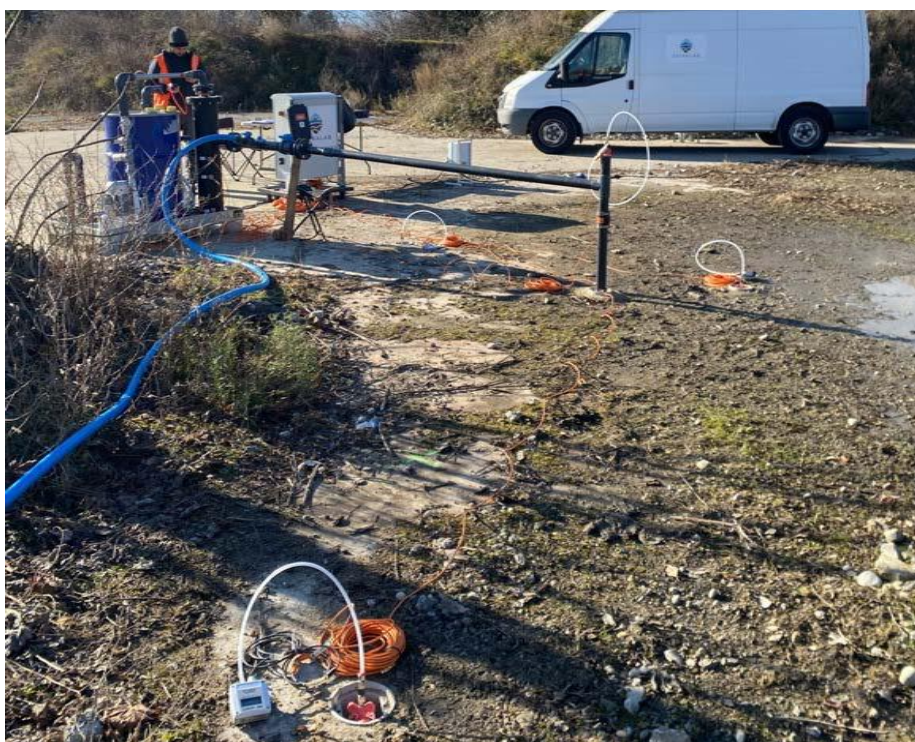
Essai pilote sur site de venting
