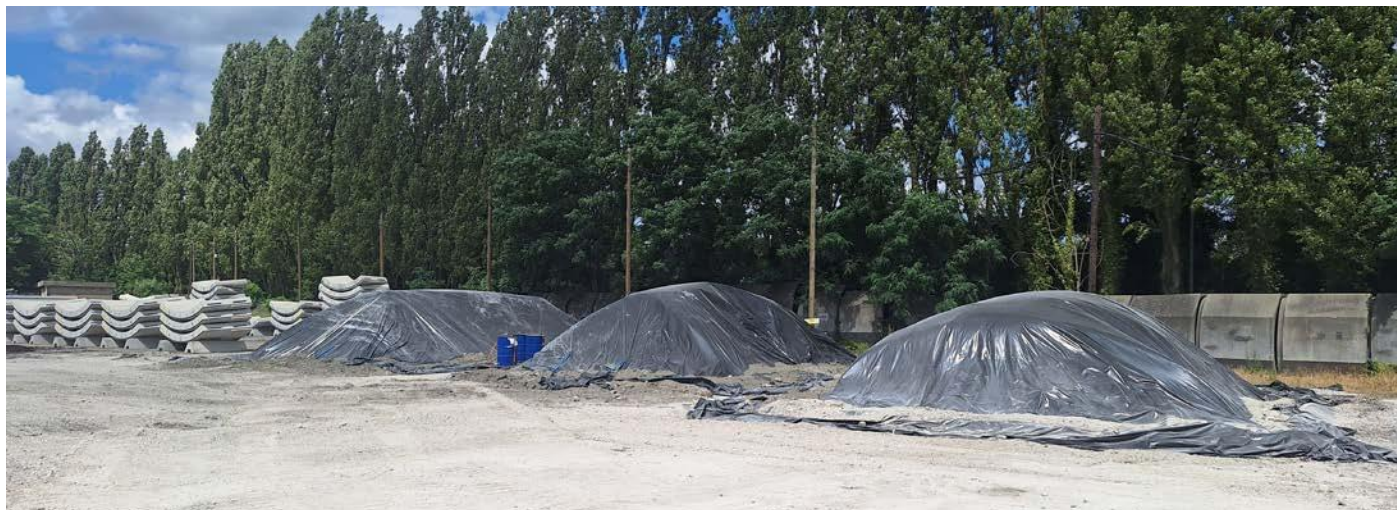
Figure 3 : Mise en place de 3 biotertres pilotes
